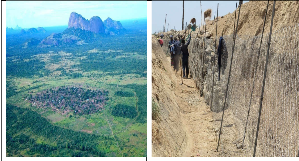
Figura 2: Aldeia de Mbamba circulado pela trincheira.
